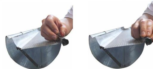
4. Части сетки укладываются с нахлестом 25 мм. Зафиксируйте местастыка сеток с помощью стальных оцинкованных саморезов 5x10 мм (рекомендуется использовать саморезы с крупным шагом резьбы и цинковым покрытием толщиной 6 мкм).
