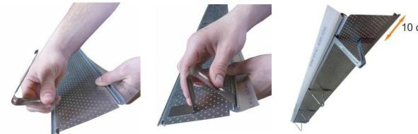
2. Расположите сетку в желобе силиконовым уплотнителем к зданию. В сторону здания должен быть небольшой наклон и силиконовый уплотнитель не должен заходить под капельник.
